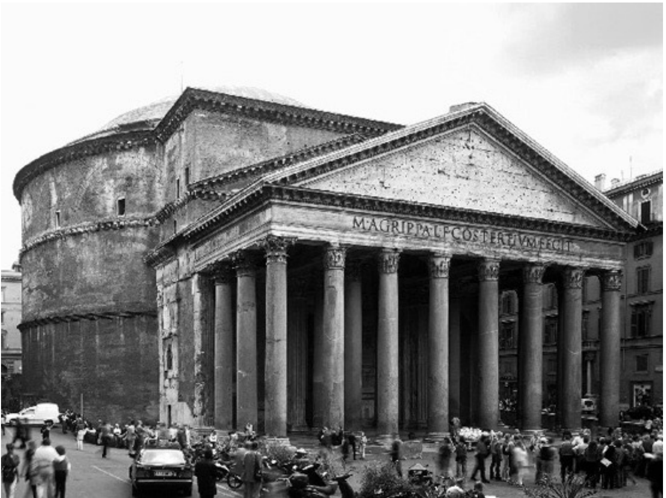
El Panteón de Roma. Marco Agripa planeó originalmente este templo, pero Adriano lo completó tal y como está en su forma actual y lo dedicó a todos los dioses. El pórtico tradicional lleva a una sala circular de 43,3 metros tanto de diámetro como de altura, iluminado por una sola abertura circular de nueve metros de diámetro. La inscripción sobre el pórtico menciona la obra original de Agripa: Marco Agripa, hijo de Lucio, cónsul por tercera vez, lo hizo.
